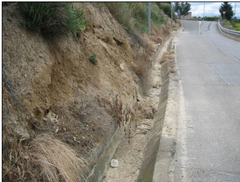
Ilustración 38. Efectos de deslizamiento por acumulación de agua.
